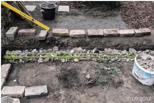
Schotter und Eisenstange bilden nun die Grundlage für das Fundament. Der Schotter fiel bei den vorhergegangenen Arbeiten am Haus an.
