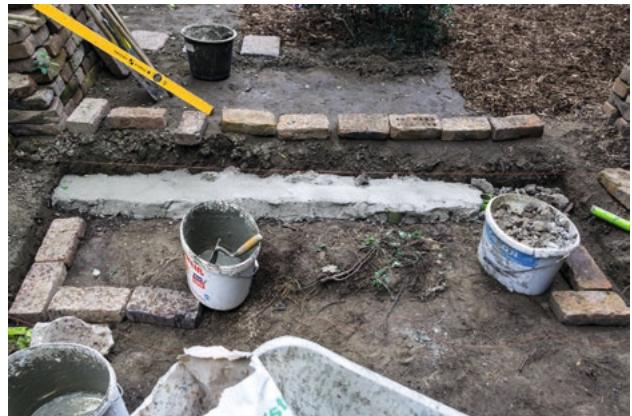
Das Ganze wird jetzt mit Betonmörtel verfestigt und aufgebaut.
